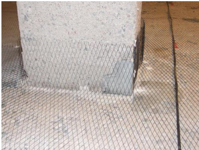
Figur 1.3 Anodsystem med nätanod av titan belagt med MMO (Mixed Metal Oxide)
