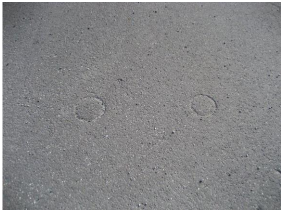
Figur 1.2 Exempel på skador i form av sjunkmärken för gjutasfalt (t v) och slitage för hårdplast (t h)
