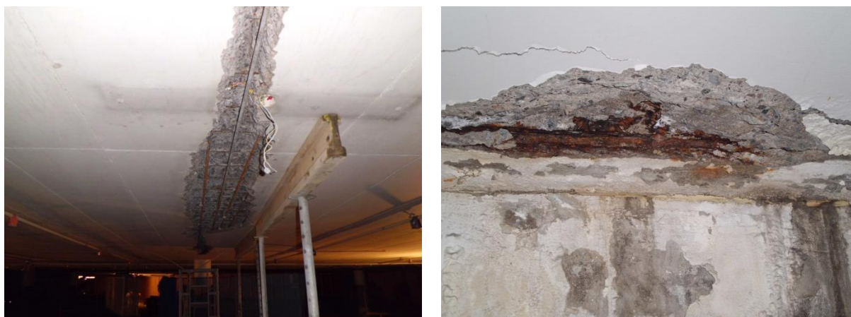
Figur 3.4 Delaminerad betong på grund av kraftiga korrosionsangrepp på armering i golv/tak i parkeringsgaraget under Skrapan i Västerås (Foto: B Sederholm)
