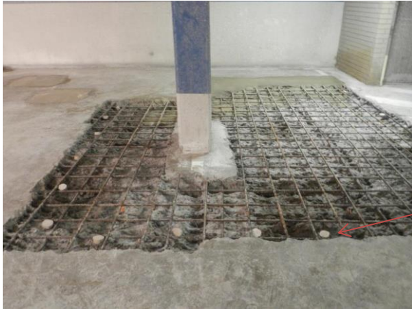
Figur 3.5 Frambilad armering med offeranoder av zink (Galvashield XP) med ett cementhölje innehållande litiumhydroxid (LiOH) (Foto: B Sederholm)
