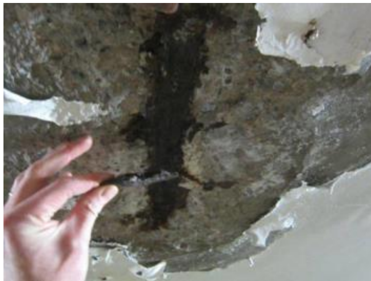
Figur 3.6 Delaminerad betong p g a armeringskorrosion i betonggolv (Foto: B Sederholm)
