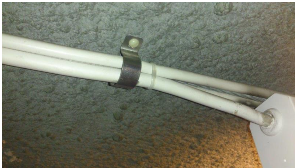
Figur 3.3 Fästelement till bygel monterad i sprutbetong med titannät och armering (Foto: B Sederholm)
