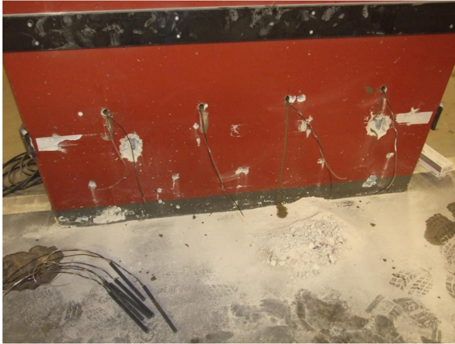
Figur 3.1 Pelare med inmonterade insticksanoder (Foto: B Sederholm)
