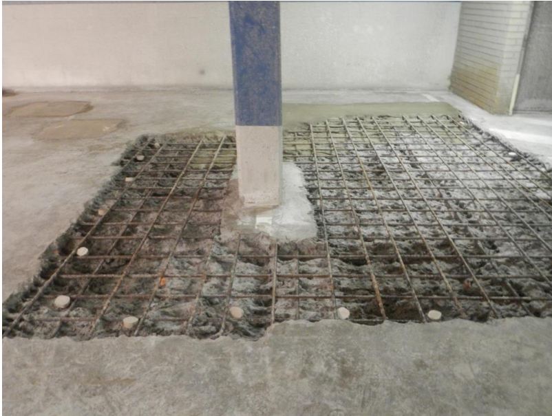
Figur 2. Installation av katodiskt skydd med offeranoder av zink med cementsludge (Galvashield XP) i parkeringshuset Skrapan, Västerås
