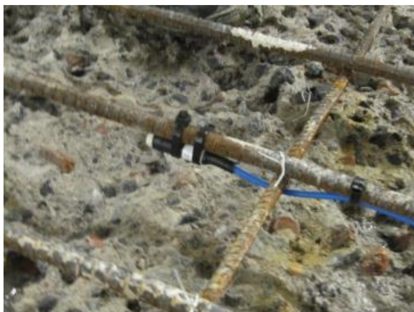
Figur 3.8 Monterad referenselektrod av \text{MnO}_2 före ingjutning. Referenselektroden används för bestämning av det katodiska skyddets skyddsförmåga (Foto: B Sederholm)
