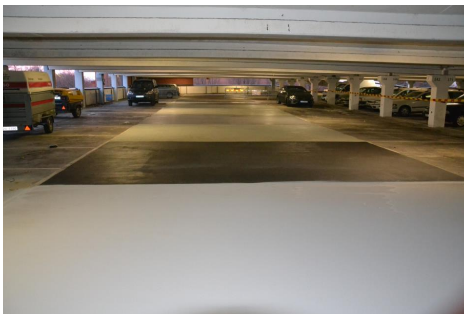
Figur 2.1 Färdig total provyta med nio beläggningssystem - Kville 2013
