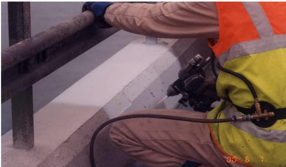
Figur 1. Installation av katodiskt skydd med termiskt sprutad offeranod av zink på Ölandsbron(2,4)
