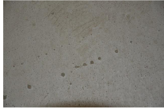
Figur 2.5 Krackelering (t v) på yta 5 (2016) och pinholes (t h) på yta 6 (2015) (Foto: Y Edwards)
