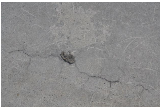
Figur 2.6 Krackelering/mindre skador (t v) på yta 5 (2016) och vidhäftningssläpp (t h) på yta 4 (2016) (Foto: Y Edwards)
