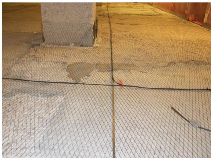
Figur 3.2 Montering av anodnät av titan på betonggolv och nedre del av pelare i parkeringsgaraget på Blasieholmen 24 (Foto: B Sederholm)
