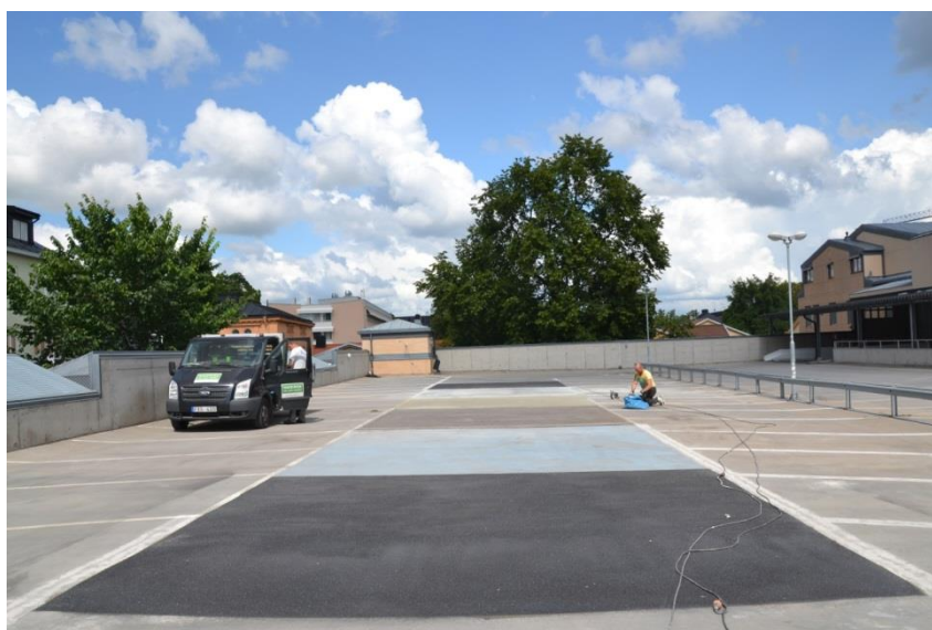
Figur 2.3 Färdig total provyta med sju beläggningssystem - Baggen 2015 (Foto: Y Edwards)
